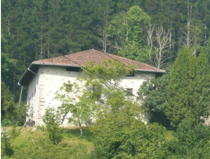
Añibarro-Dañonena baserriaren argazkia
